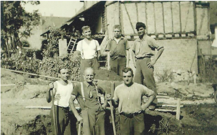
Bild von den Ausschachtarbeiten:
